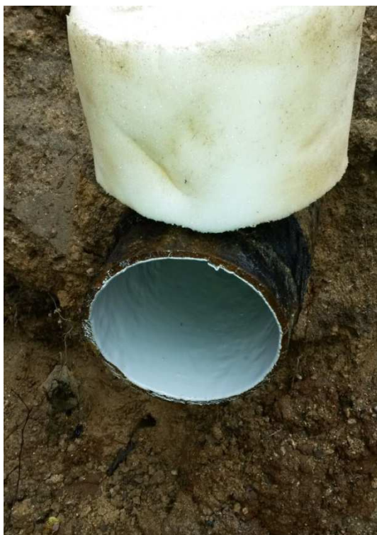
Obrázek 4. Polyuretanový nástřik na potrubí v Tanvaldě (© Říha 2015)
