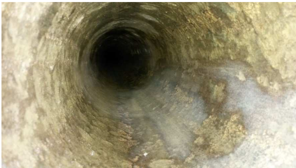
Obrázek 1. Vysušené potrubí připravené k aplikaci polyuretanu (© Říha 2015)
