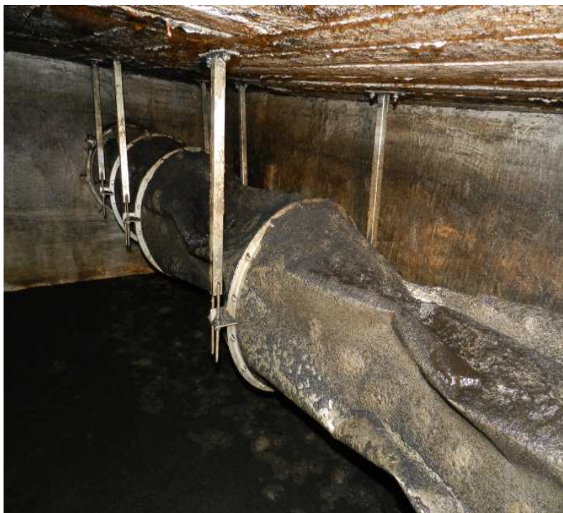
Obr. 2. Zdeformovaný trubní systém
